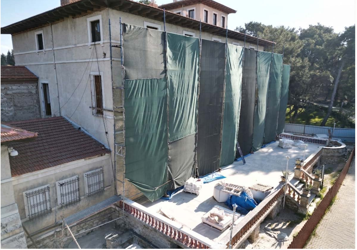
Rees Köşkü Restorasyonu
