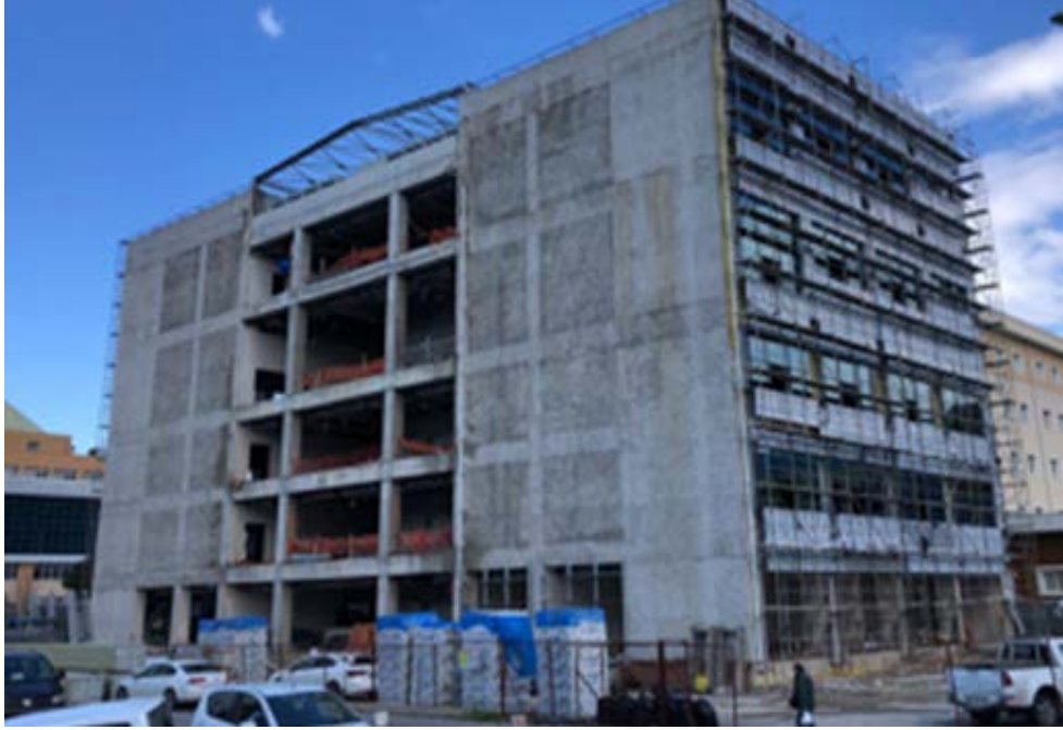
Resim 2: İnciraltı Yerleşkesi Hemşirelik Fakültesi Derslik Binası İnşaatı
