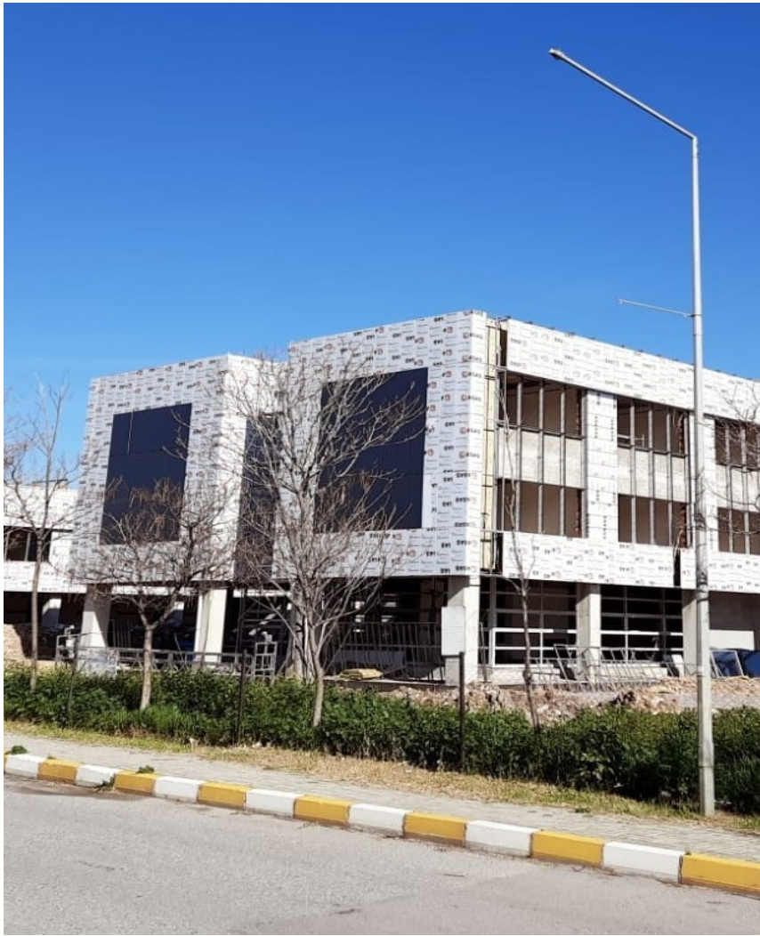
Resim 1:Yabancı Diller Yüksekokulu İnşaatı
