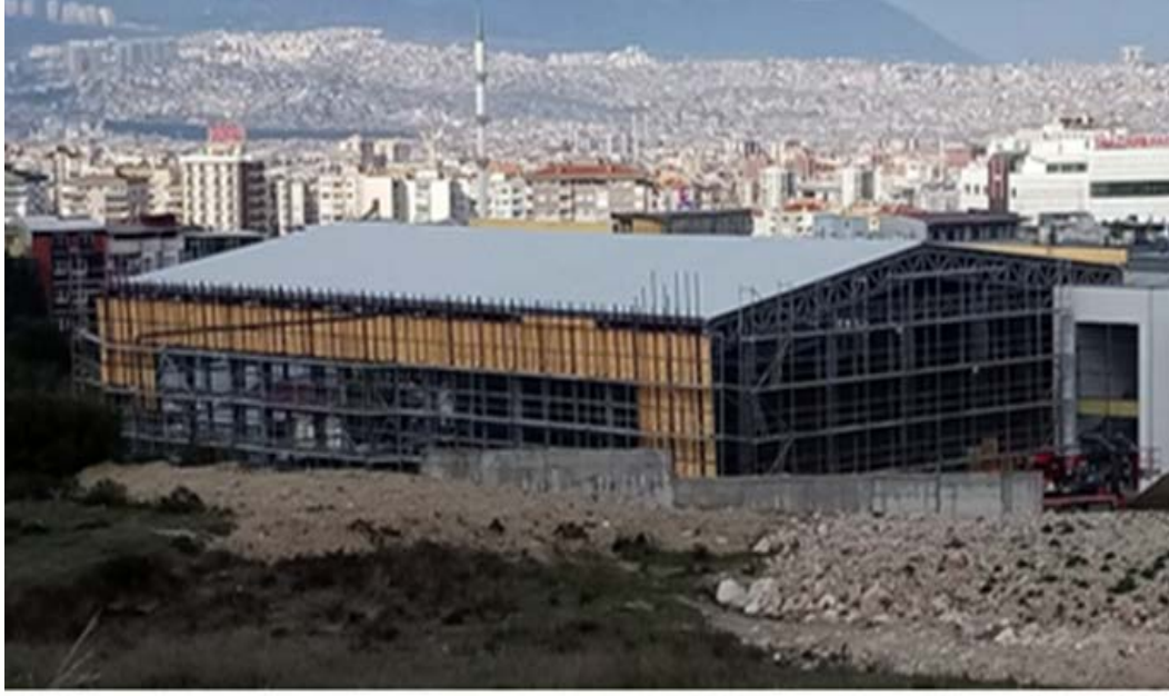
Resim 3: Yarı Olimpik Yüzme Havuzu İnşaatı
