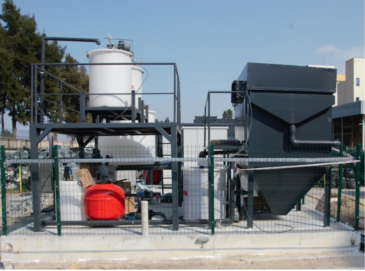
Uygulama ve Araştırma Hastanesi Atık Su Arıtma Tesisi Yapılması İşi
