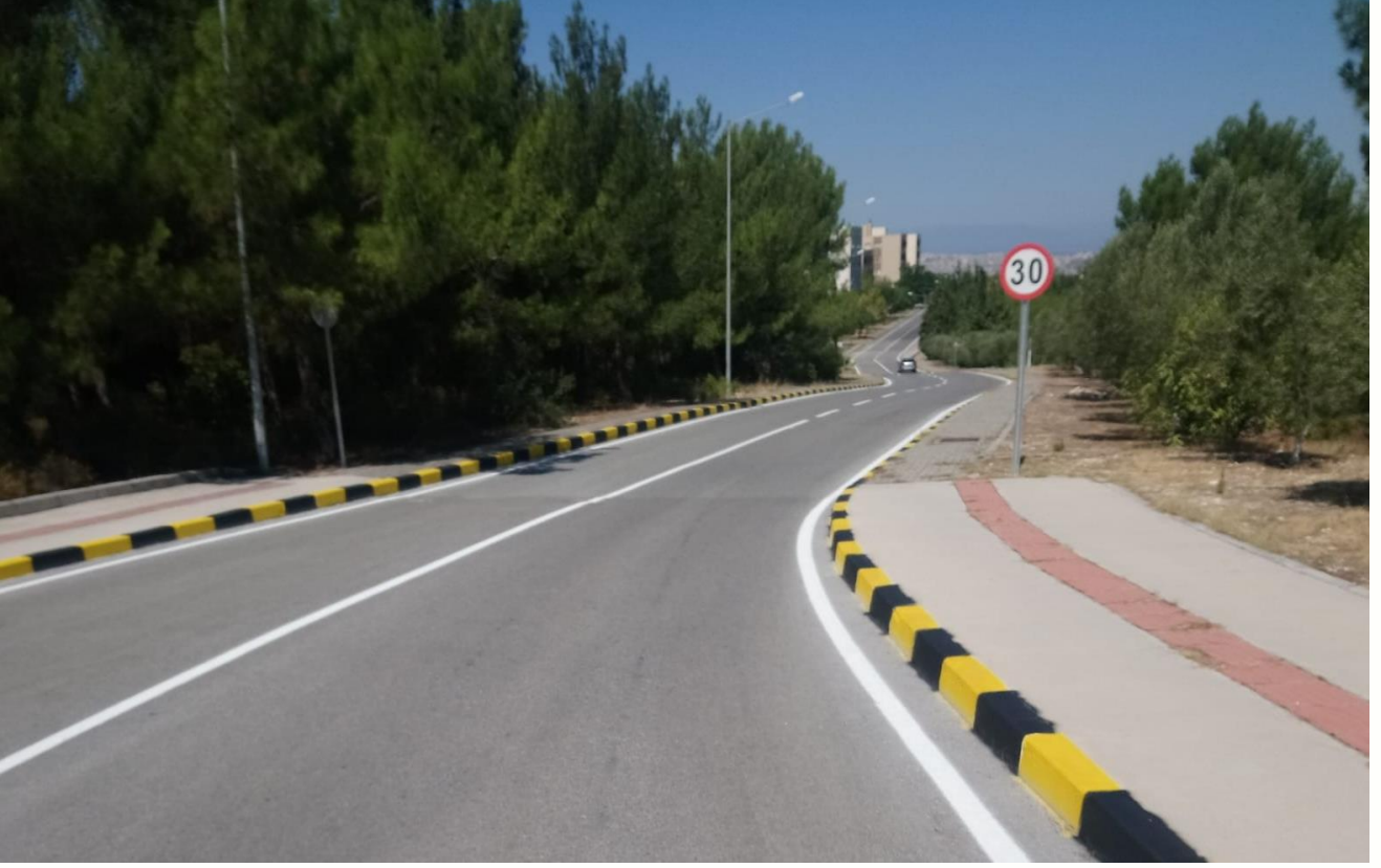
Merkez Yerleşkesi Bordür ve Yol Çizgisi Boyama İşİ
