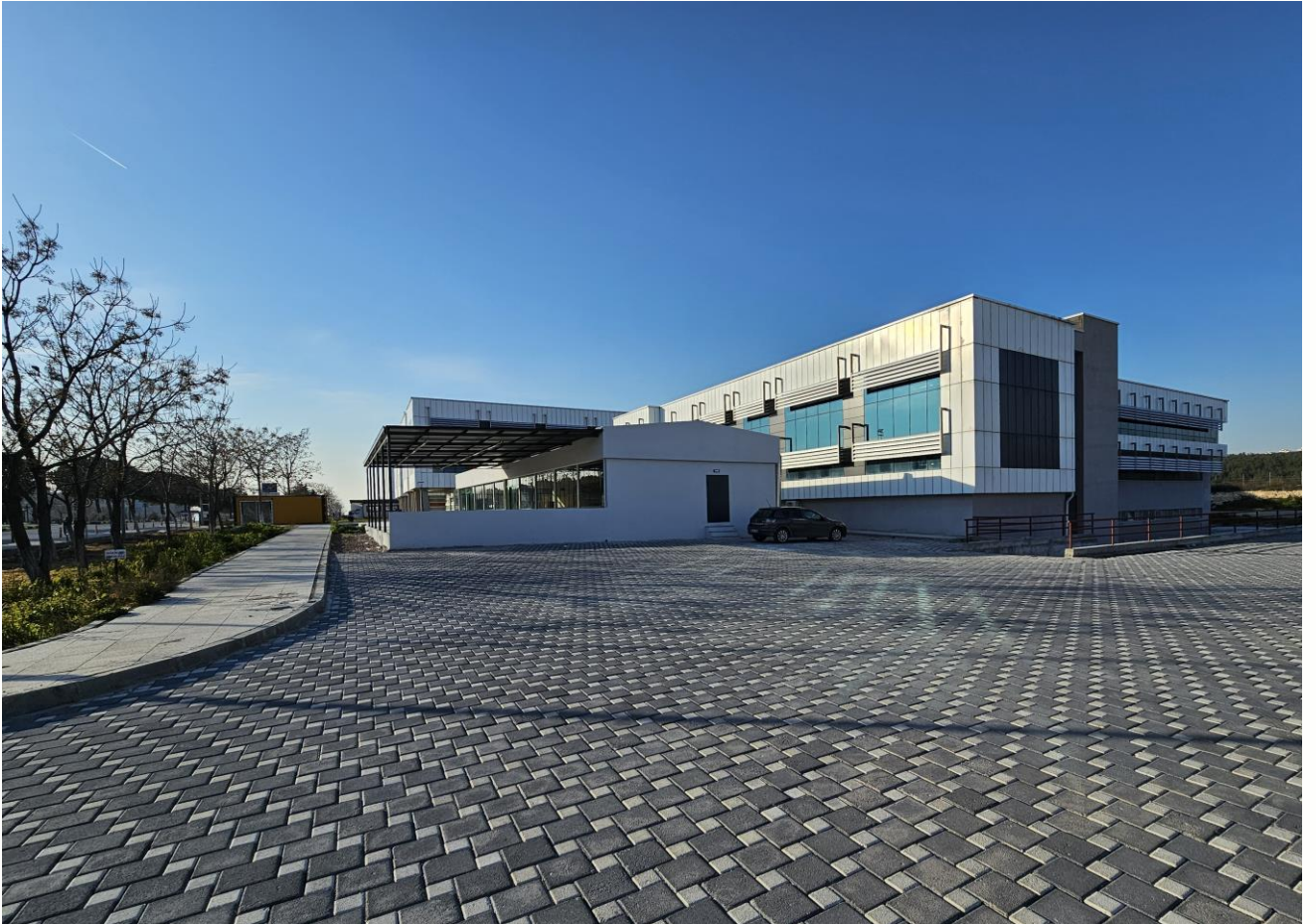
Merkez Yerleşkesi Yabancı Diller Yüksekokulu Çevre Düzenlemesi ve Yağmur Suyu Drenaj Hattı Yapılması İşİ
