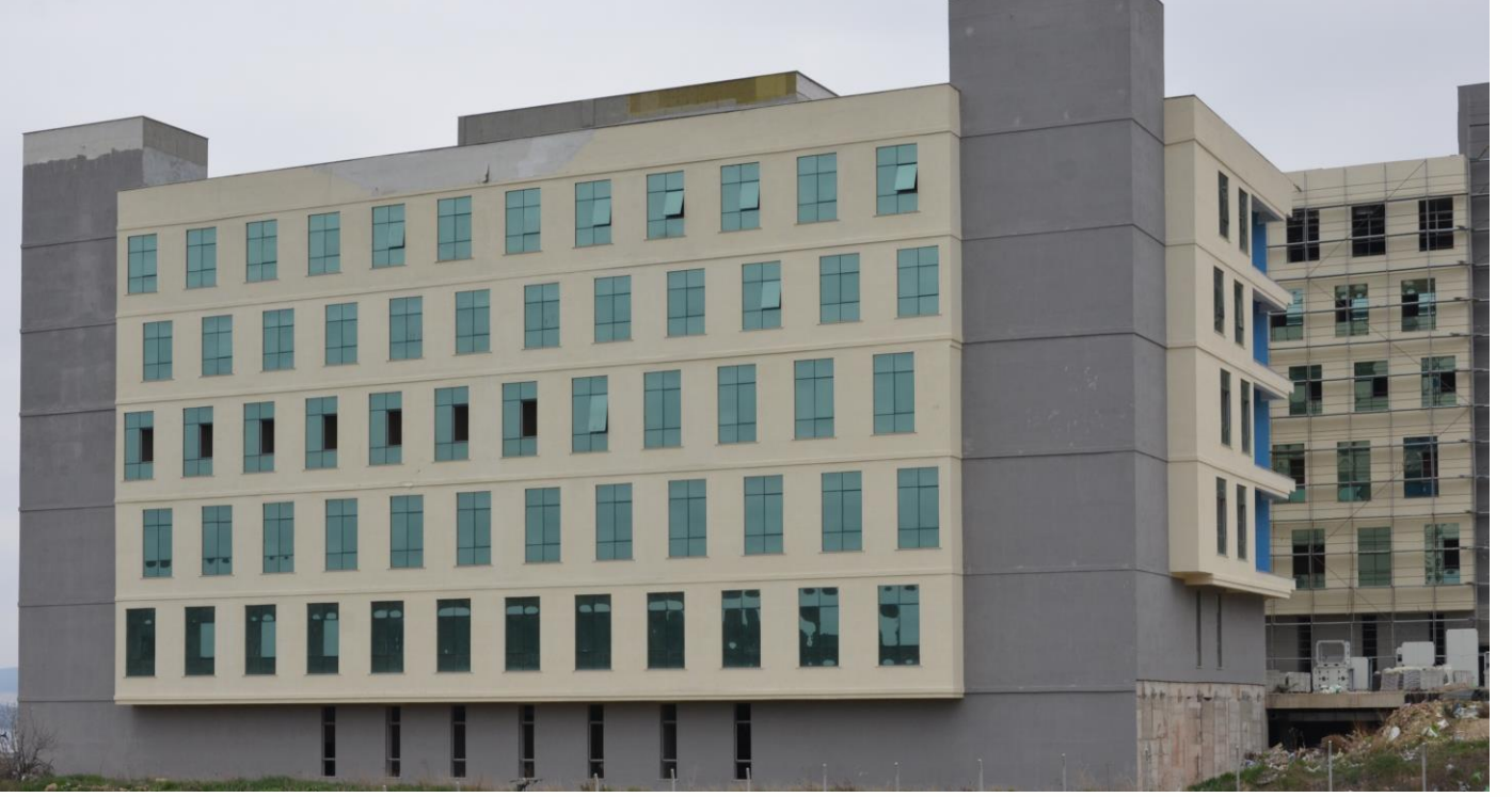
Aliğa Mesleki ve Çevresel Hastalıklar Hastanesi İnşaatı
