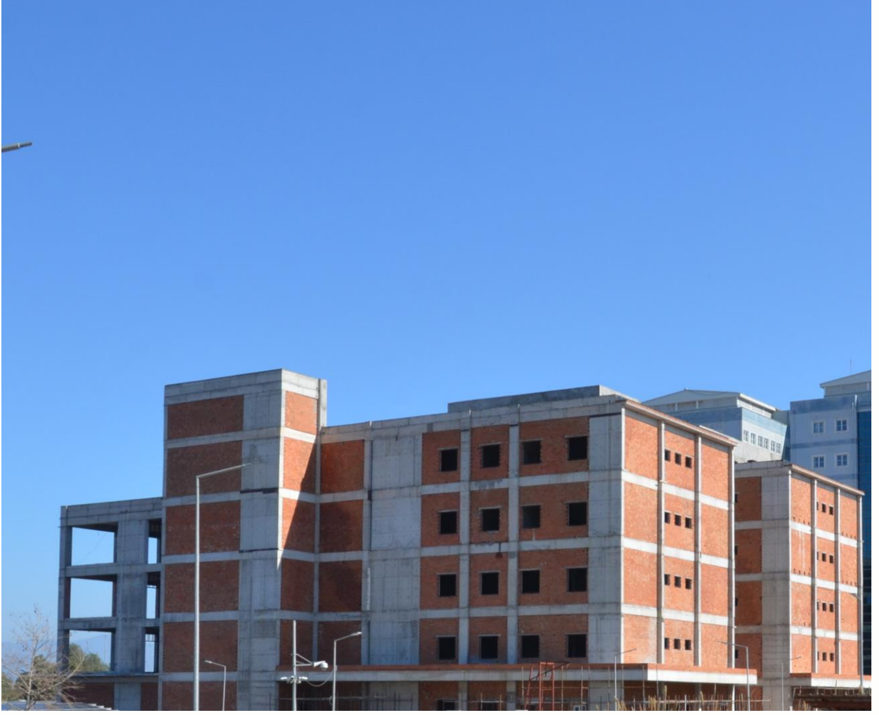
Merkezi Yemekhane Binası İnşaatı
