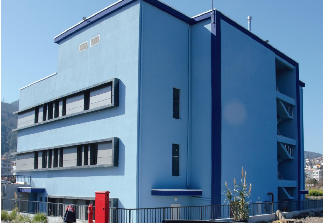
Büyük Deney Hayvanları Araştırma Alt Yapısı İnşaatı
