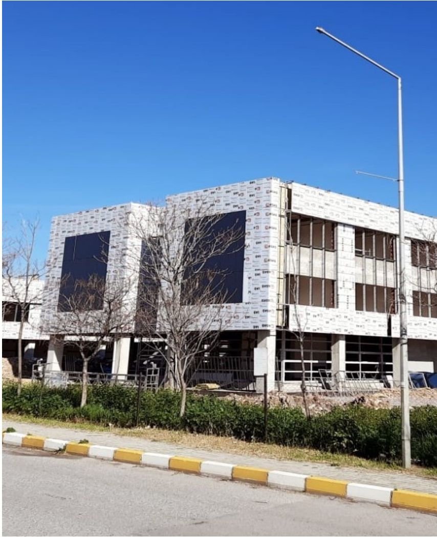
Resim 1:Yabancı Diller Yüksekokulu İnşaatı
