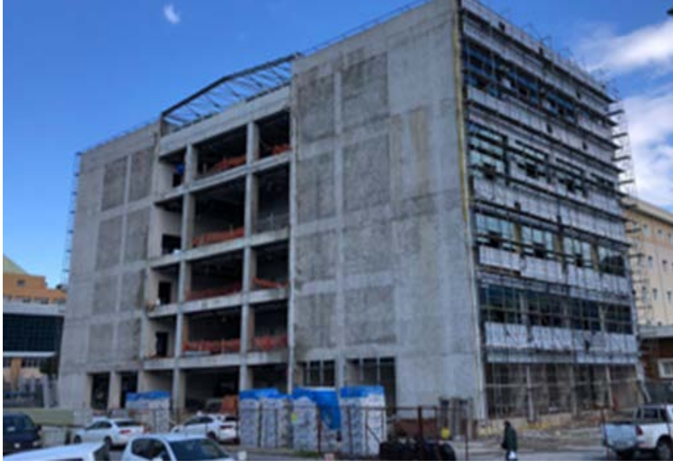
Resim 2: İnciraltı Yerleşkesi Hemşirelik Fakültesi Derslik Binası İnşaatı
