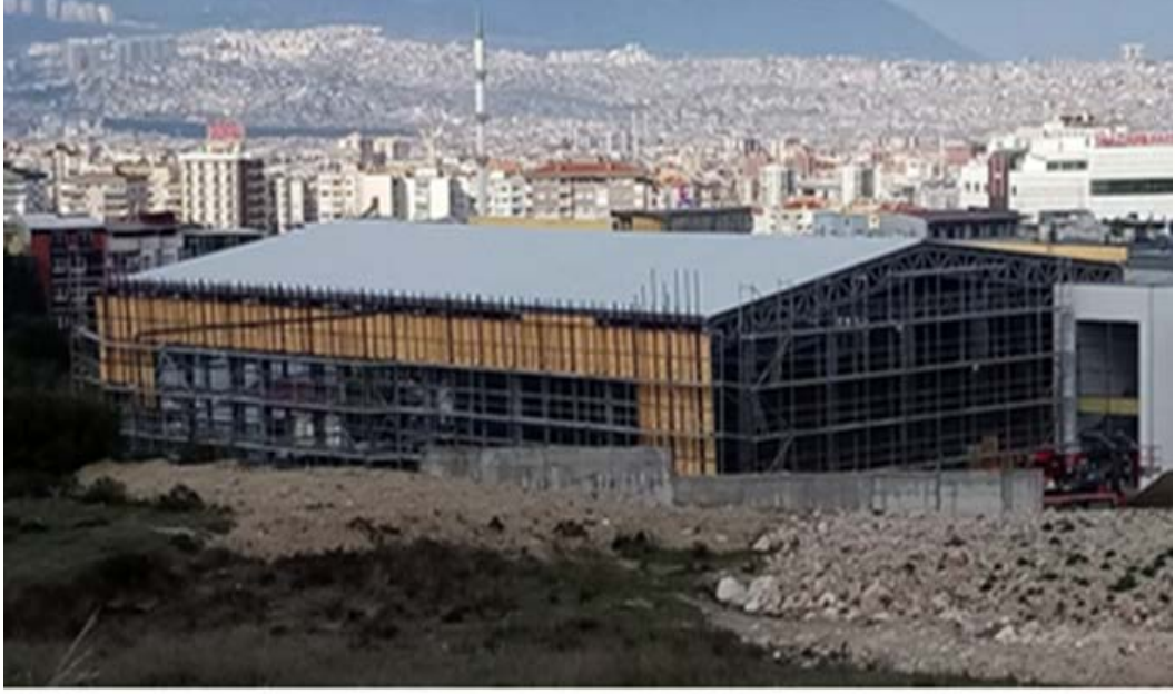
Resim 3: Yarı Olimpik Yüzme Havuzu İnşaatı
